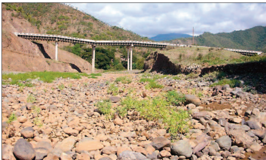
Puente dañado por una avenida catastrófica en la boca del río Peladeros.
